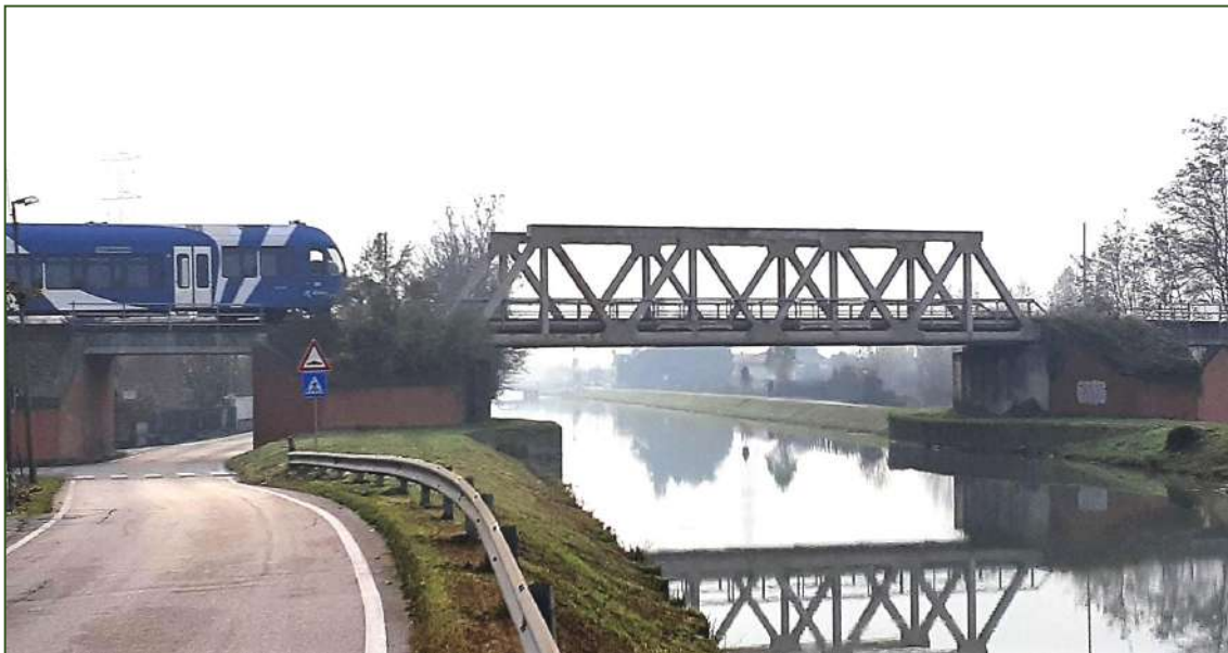
Comune di Mira – Ponte sul fiume Novissimo
